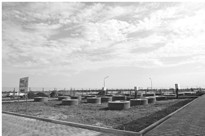
Рисунок 1 – Гвардейские канализационные очистные сооружения после реконструкции [3]
