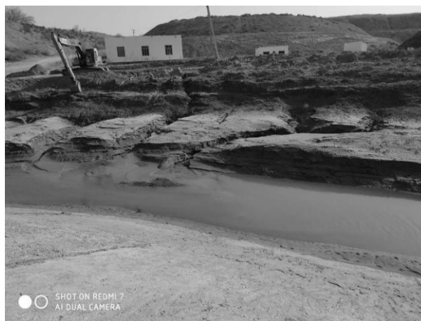
Рисунок 1 – Разрушение откосов подводящего канала насосной станции «Кизил-Тепе» (автор фото НИИИВП)
