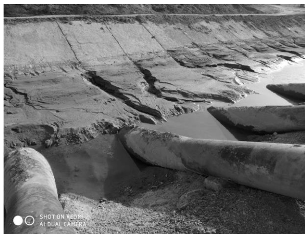
Рисунок 1 – Разрушение откосов подводящего канала насосной станции «Кизил-Тепе» (автор фото НИИИВП)
