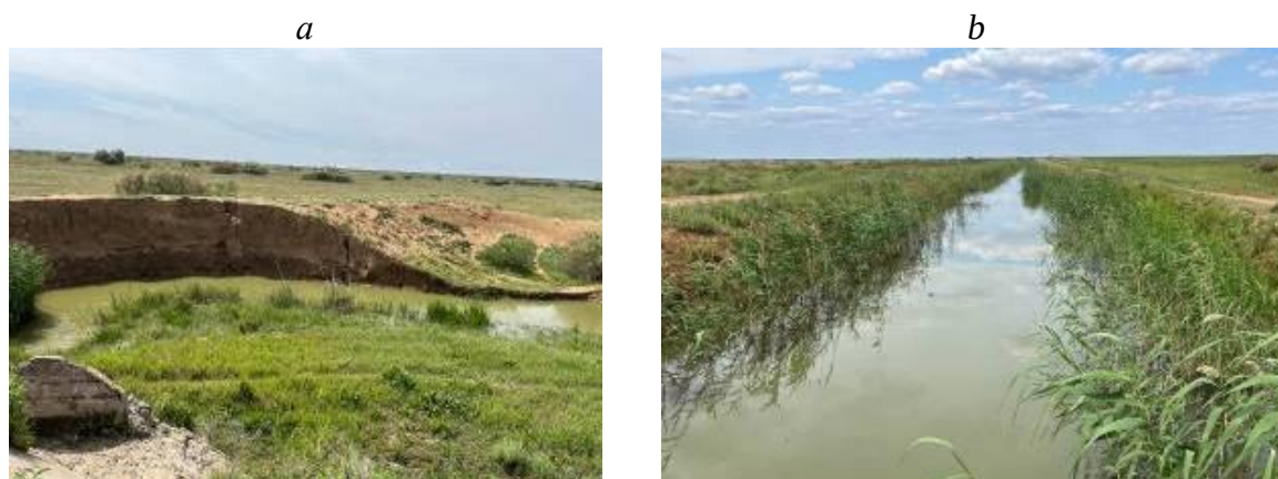
a – нарушения профиля сечения; b – заиливание и зарастание русла
