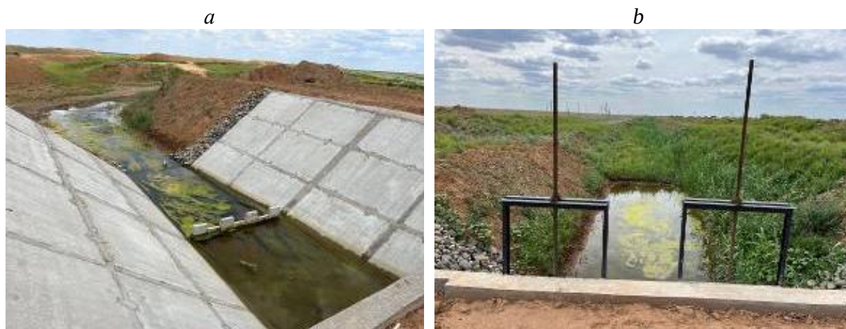
a – нижний бьеф; b – русло канала в верхнем бьефе a – downstream; b – canal bed in the upstream
