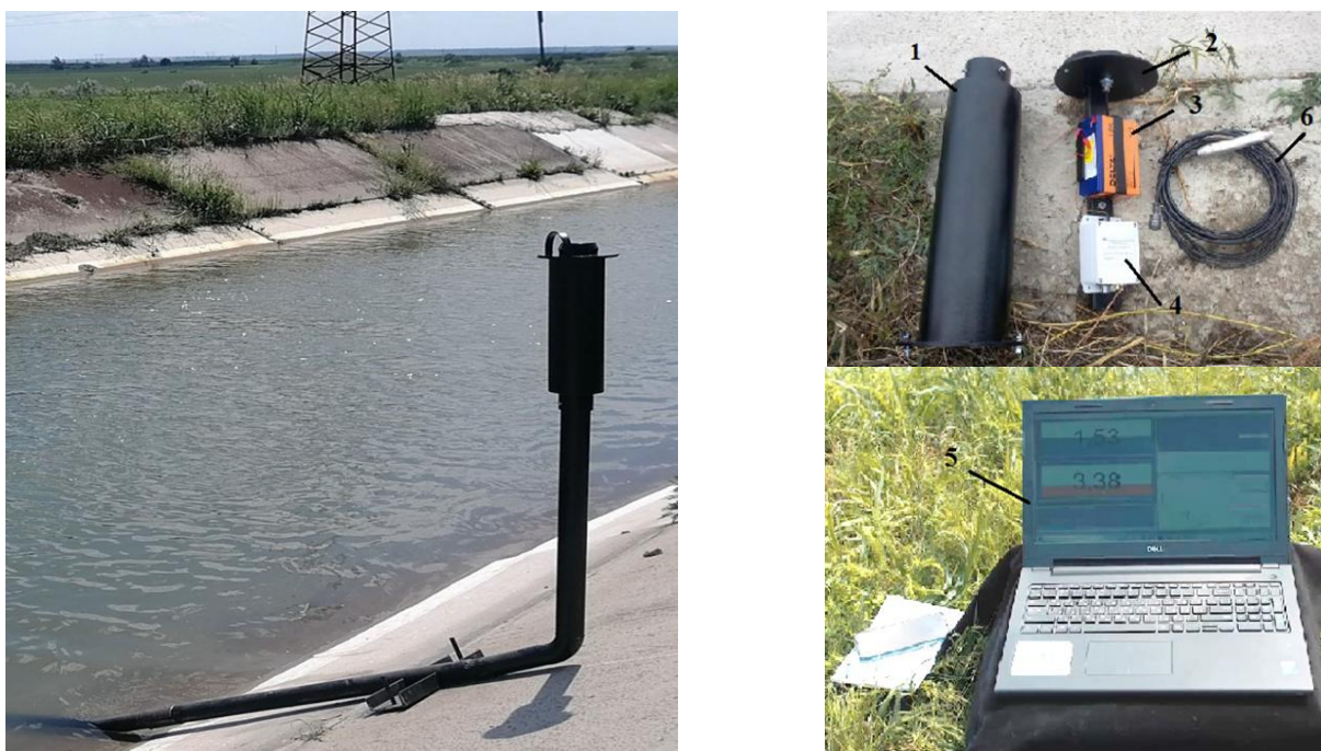
1 – антивандальный корпус; 2 – антенна GSM; 3 – контроллер-модем; 4 – аккумуляторная батарея; 5 – персональный компьютер; 6 – датчик уровня воды 1 – vandal-proof case; 2 – GSM antenna; 3 – controller-modem; 4 – battery; 5 – personal computer; 6 – water level sensor
