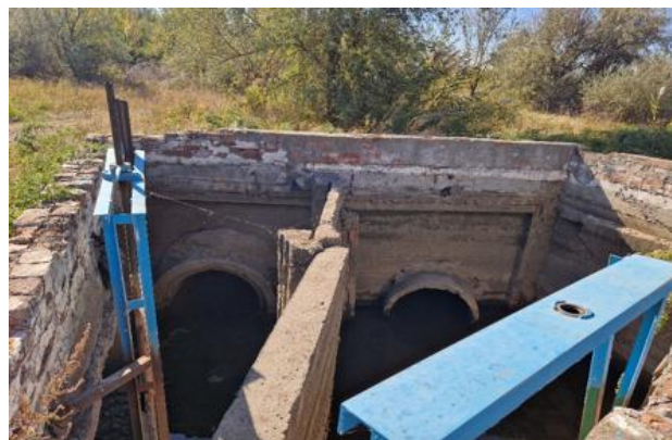
Межхозяйственный водораспределительный узел
