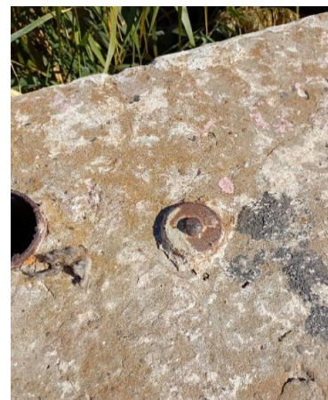
Высотная закладная марка на бетонном парапете дюкера Elevation embedded mark on the concrete apron of the siphon
