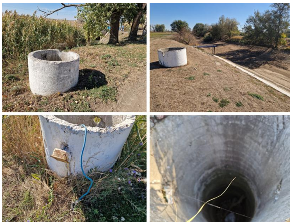
Рисунок 8 – Успокоительные колодцы по трассе Азовского магистрального канала (автор фото В. Д. Гостищев)
