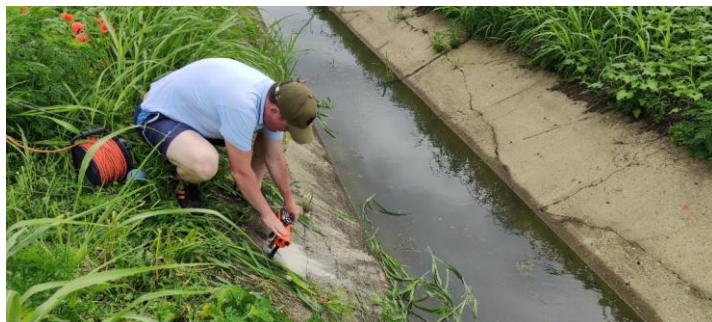
Рисунок 4 – Определение фактической прочности бетона (автор фото В. Г. Дегтярев)
