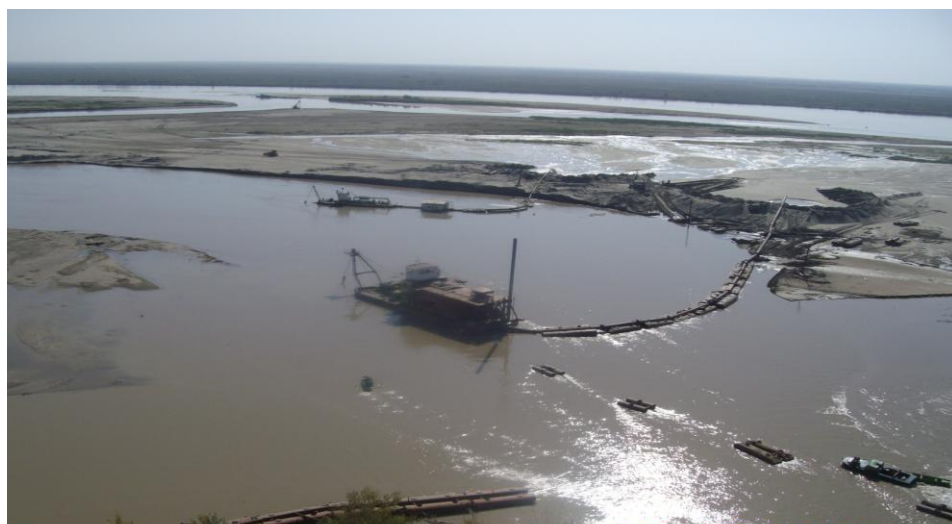
Рисунок 1 – Очистка углубленного участка канала земснарядами (автор фото О. Я. Гловацкий)
