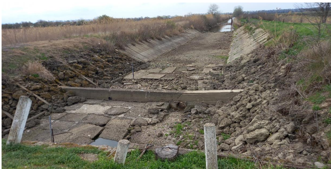
Рисунок 3 – Крепление откосов наброской (автор фото Д. С. Рыбалко) Figure 3 – Slope strengthening with filling (photo by D. S. Rybalko)
