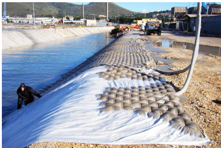
Рисунок 5 – Укладка бетонных матов (источник фото https://www.td-meaplast.ru/production/geosintetik/geobolochki/betonnii-mati-meablok-t/ )
