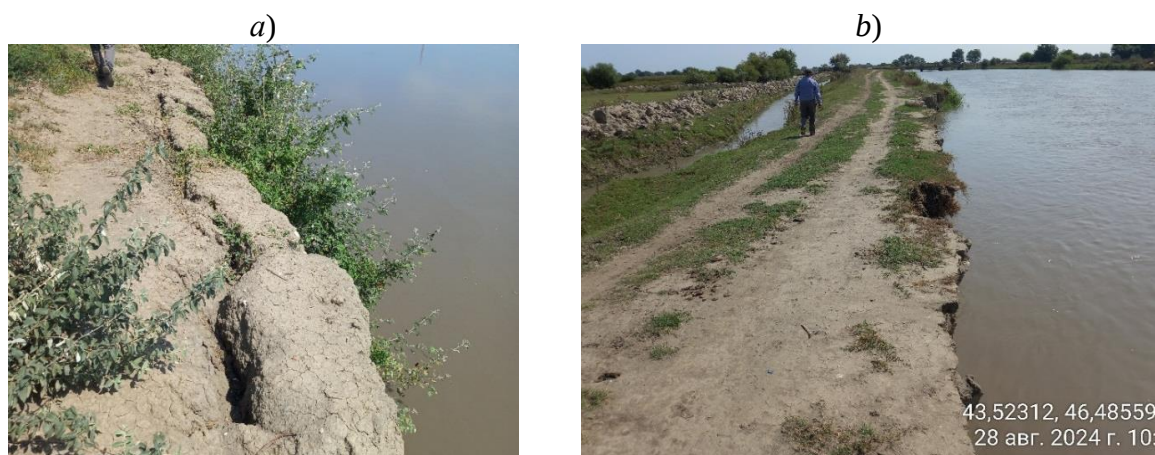
a – обрушение эксплуатационной дороги; b – процесс размыва русла доходит до внутрихозяйственного канала
